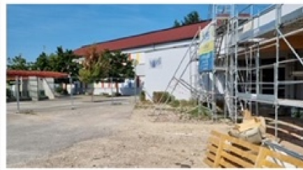
Les travaux de l'extension du périscolaire à Dingsheim. Photo E.K.
