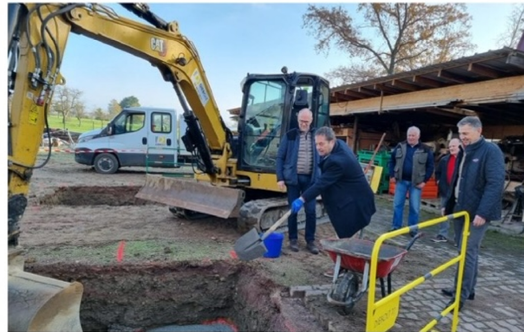
Les travaux d'extension du musée ont commencé, symboliquement mis en scène par le maire Bruno Lorentz. Photo Simone Giedinger
